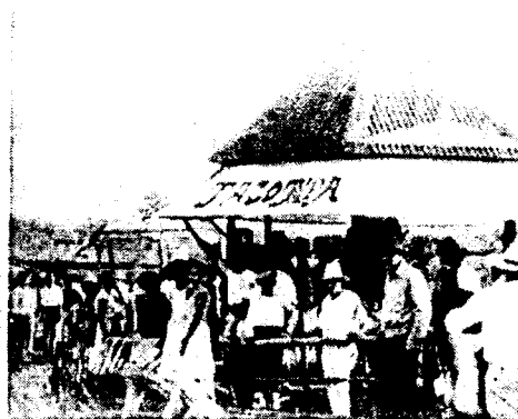
Kiosko del municipio de Tacotalpa
